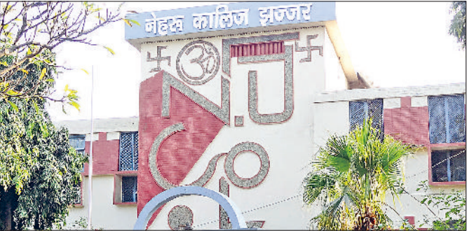
झज्जर। राजकीय स्नातकोत्तर नेहरू महाविद्यालय का भवन।
